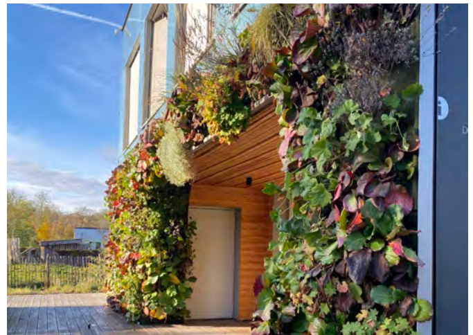
Solar Decathlon Wuppertal – nachhaltiges Bauen für die Energiewende, Foto © Gläserne Werkstatt
